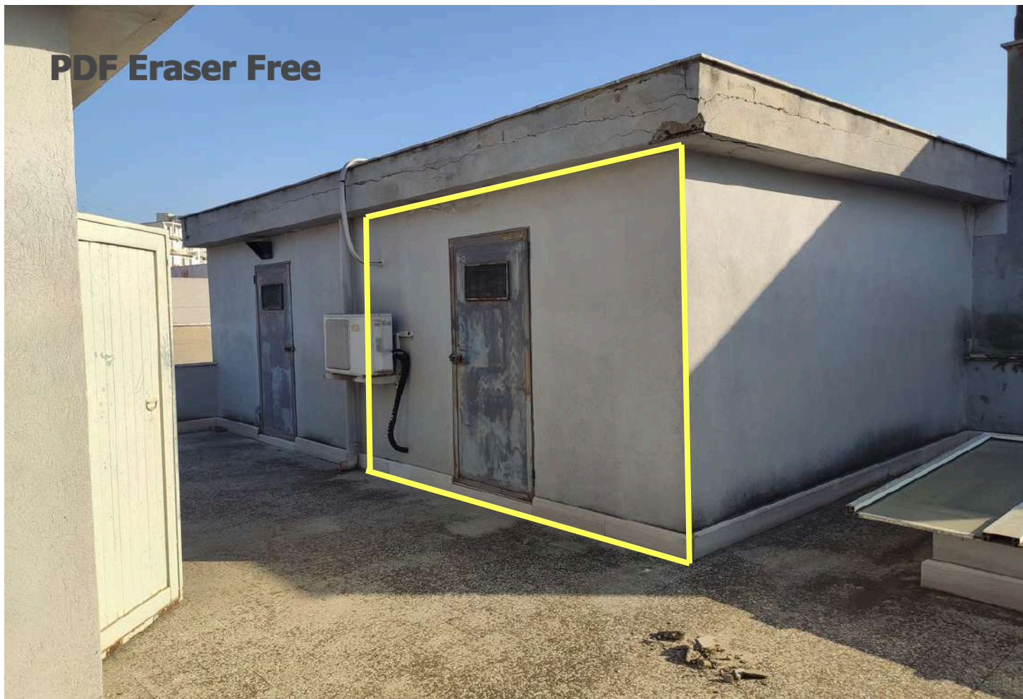
Foto 4 - Deposito Fgl. 162 P.lla 944 Sub. 11
