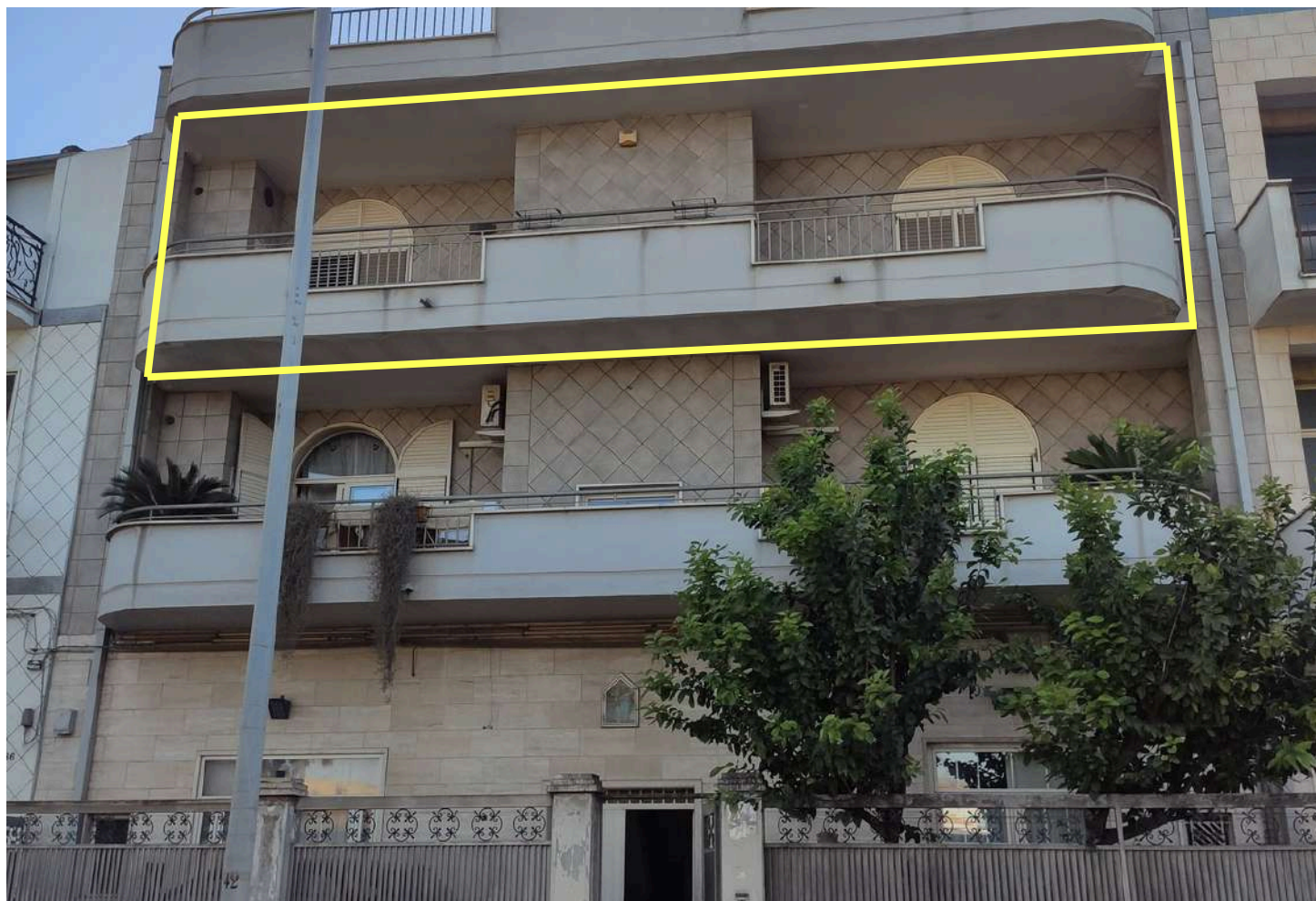
Foto 3 - Abitazione di tipo economico - Fgl. 162 P.Ila 944 Sub. 7
